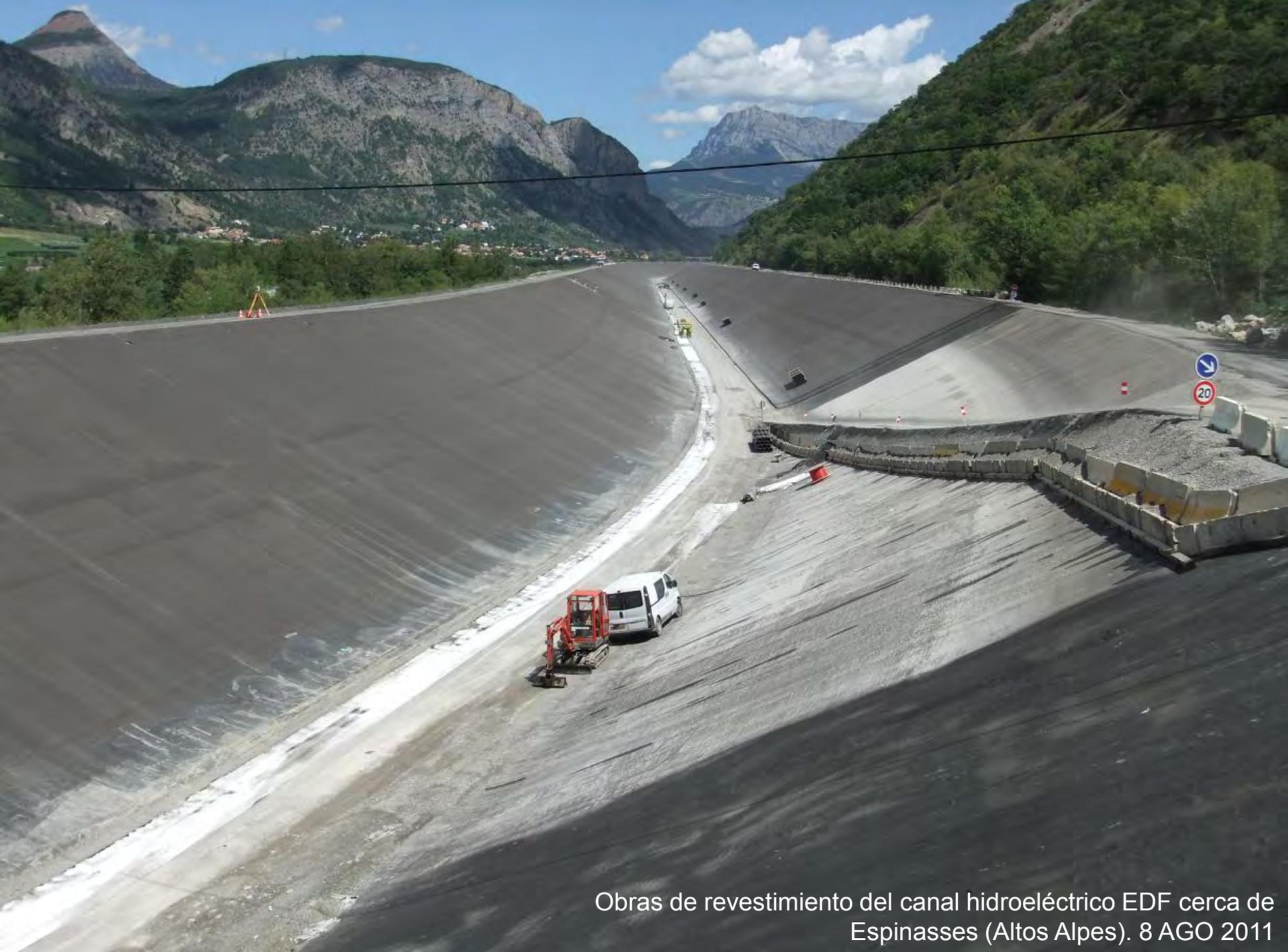
Obras de revestimiento del canal hidroeléctrico EDF cerca de Espinasses (Altos Alpes). 8 AGO 2011
